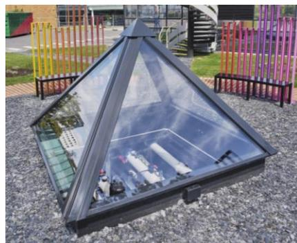
② Un local technique accueille une pompe à chaleur air/eau et les équipements tiers. La pompe à chaleur assure l'échange des calories avec le sous-sol pour les fournir au bâtiment en hiver et les en extraire en été. La fourniture simultanée de chaud et de froid est également possible ce qui est idéal pour ce bâtiment de bureaux qui a des façades exposées au nord et d'autres au sud.
